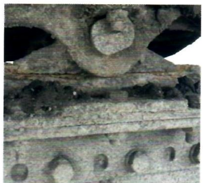
a. (2) (d) Cracked Weld
